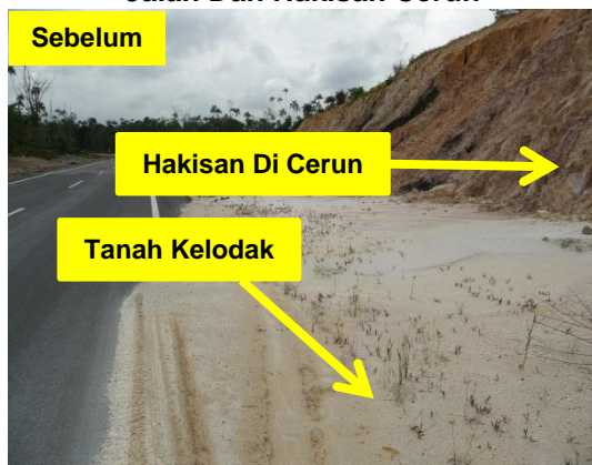
Gambar 2.6 Tanah Kelodak Di Permukaan Jalan Dan Hakisan Cerun
