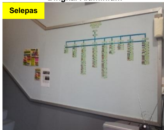
Gambar 4.16 Softboard Telah Dipasang Dengan Bingkai Aluminium
