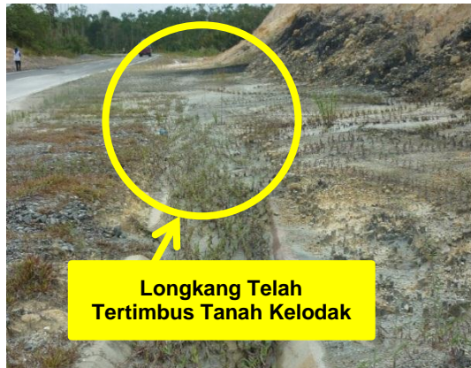
Gambar 2.3 Longkang Telah Tertimbus Tanah Kelodak
