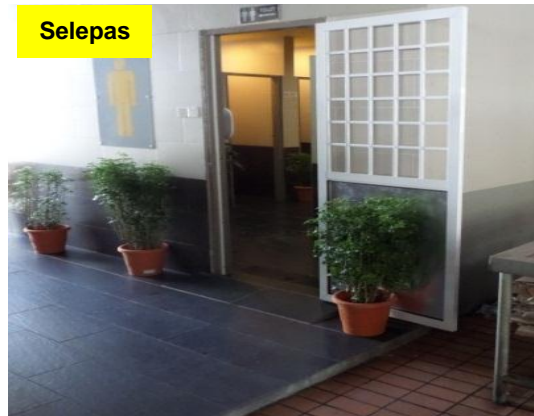
Gambar 4.10 Jeriji Aluminium Telah Dipasang Pada Pintu Utama Tandas Lelaki
