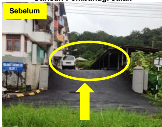
Gambar 4.7 Jalan Tidak Dicat Dengan Garis Pembahagi Jalan
