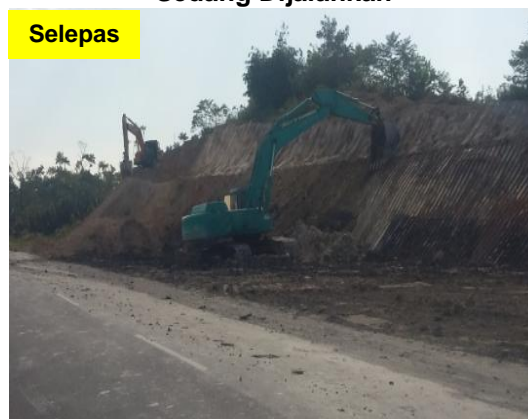
Gambar 2.7 Kerja Pembaikan Sedang Dijalankan
